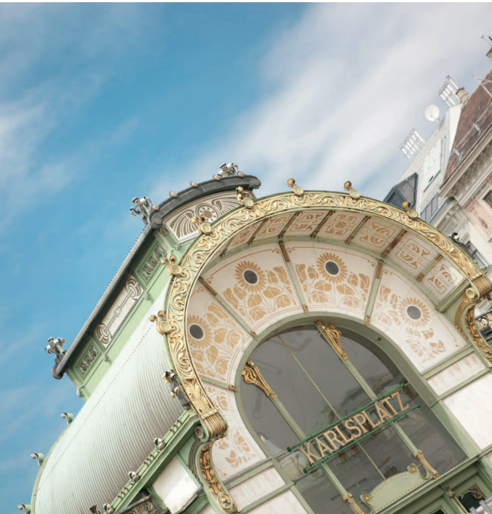
Historische Stadtbahnstation Karlsplatz, © schultz
